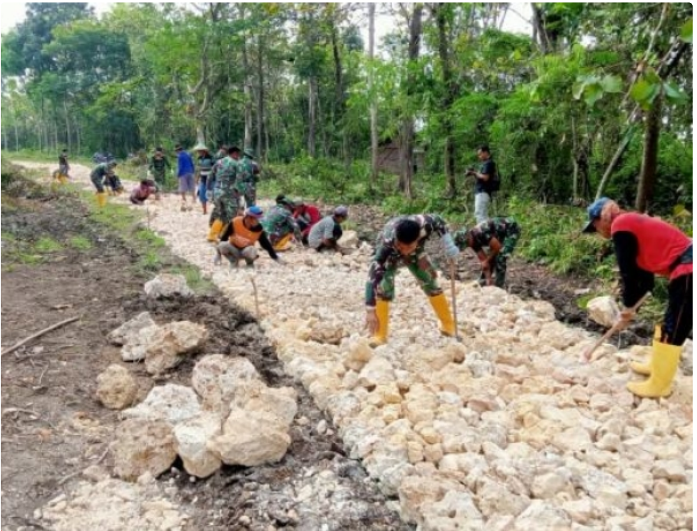
Satgas TMMD bersama warga Alasmalang gotong royong Kebut pekerjaan Sebelum Penutupan TMMD ke-113
